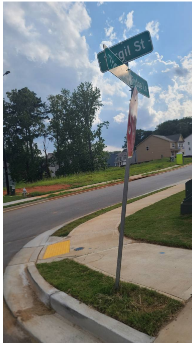
Photo 1 of 1 · REC-028_ThompsonRidgeLnVirgilStCorner_Leaning StopSign_2026-08-21.jpg
